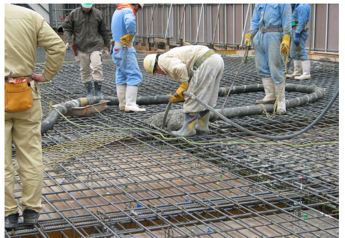
<1階床コンクリート工事>
