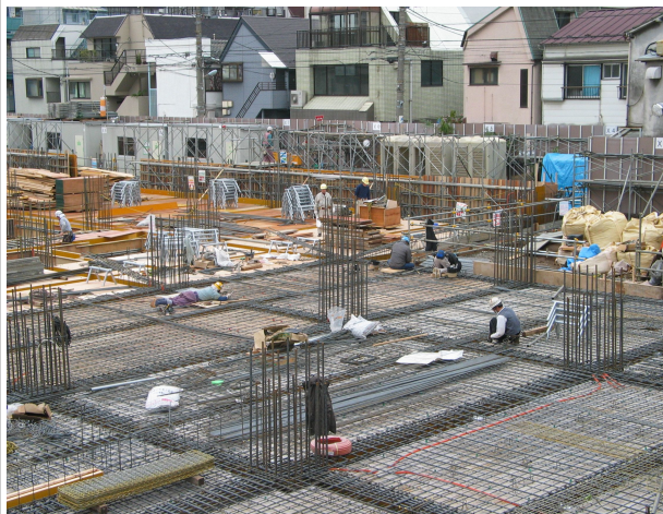
<1階床鉄筋工事>
