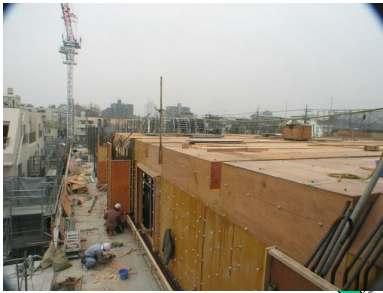
2階手術室外壁型枠
