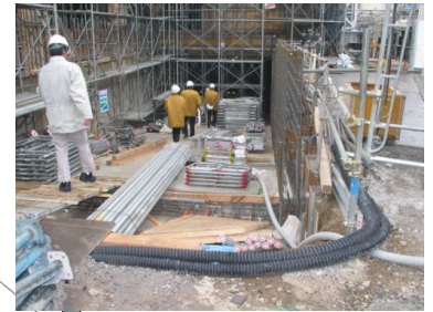
地下駐車場 入路スロープ
