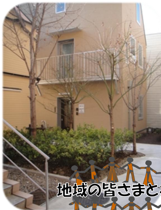
研修棟連絡通路・入口 (指導室・医療福祉相談室・地域連携室)
